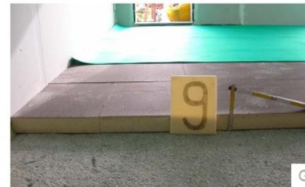
Spessore del poliuretano espanso del solaio controterra
