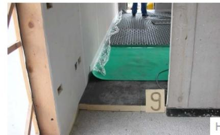
Riscaldamento a pannello radiante con materassino in EPS da 3 cm, materassino fonoisolante e poliuretano espanso nel solaio controterra
